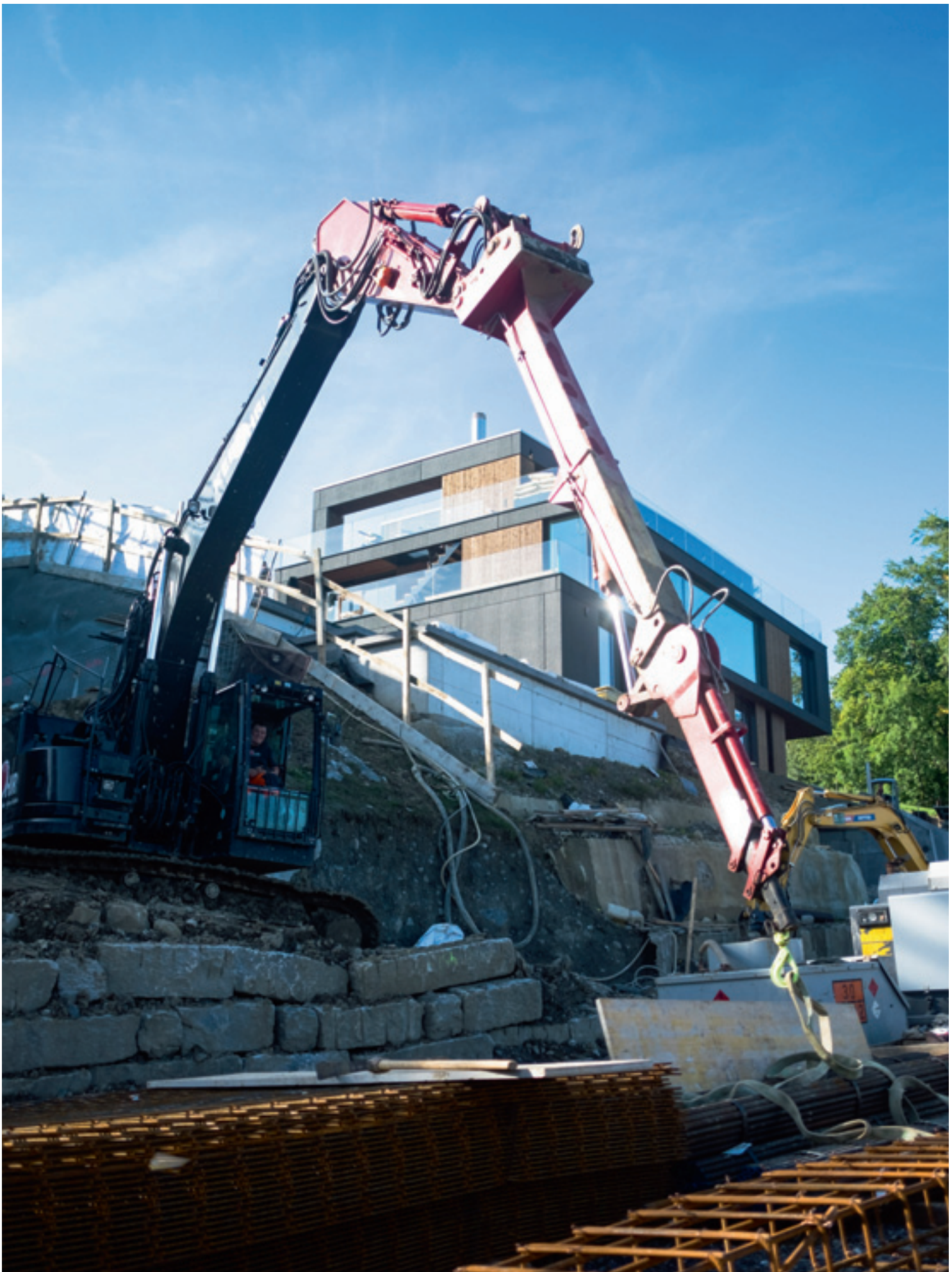
Auf der Baustelle für das Bauprojekt «lediblick.ch» werden Armierungseisen mit dem Bagger bewegt.
