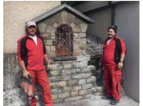
Unten rechts: Trotz schweren Maschinen – die beiden Mitarbeiter der Poli Bau AG demonstrieren das Hegenstöckli im Wylquartier mit grosser Sorgfalt.
