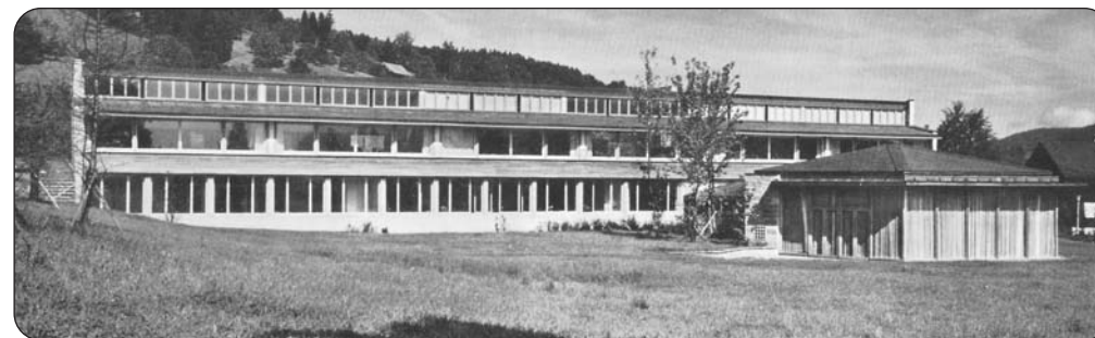
Bereits vor 50 Jahren – und noch heute – wegweisend: Das Schulhaus Matt.
