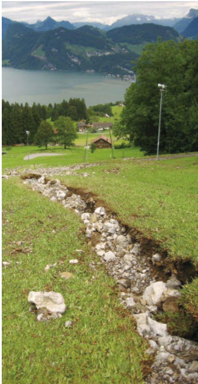
Zerstörerischer Murgang auf Langmattli.
