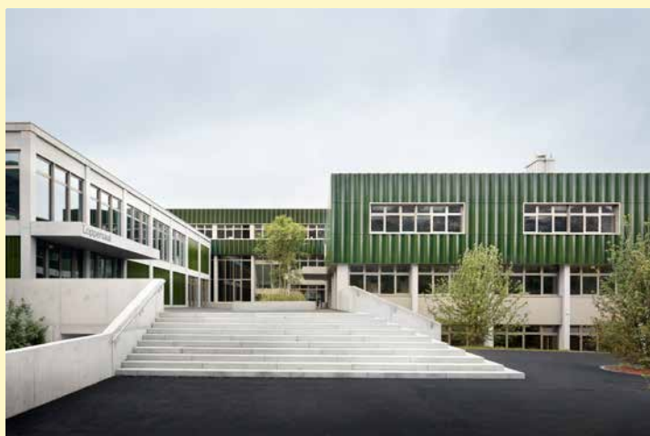
Nach einer Bauzeit von nicht ganz zwei Jahren steht das Schulhaus Grossmatt seit den Osterferien 2019 wieder dem Schulbetrieb und der Hergiswiler Bevölkerung zur Verfügung.
