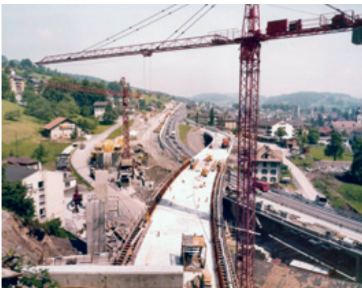
Juli 1981: Bau der Lärmschutzgalerie und der Rampenbrücken zum Loppertunnel.
