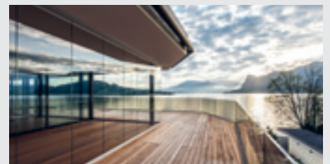
Ein Balkonanbau der Werner Keller Technik AG.
