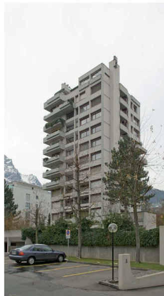
Bild oben: Ansicht von Norden Bild unten: Ansicht von Nordosten
