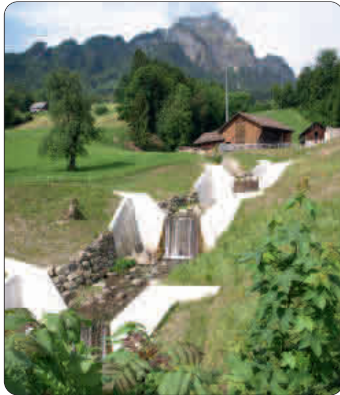
Die neusten Betonsperren im Mühlebach unterhalb des neuen Wasserkraftwerks.
