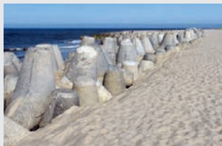
Kommen am Meer häufig zum Einsatz: Tetrapoden als Wellenbrecher. [PD]
