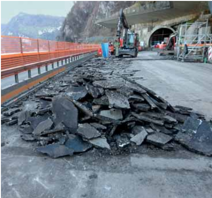
Im Februar 2022 wurde der alte Brückenbelag bis auf die Betonoberfläche entfernt.
