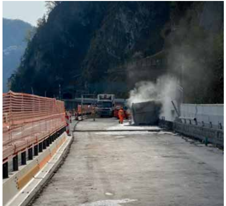
Im April 2022 wurde beim Lopperviadukt mit Wasserhöchstdruck der Beton der Randleitmauer abgetragen. (Bilder: Astra)
