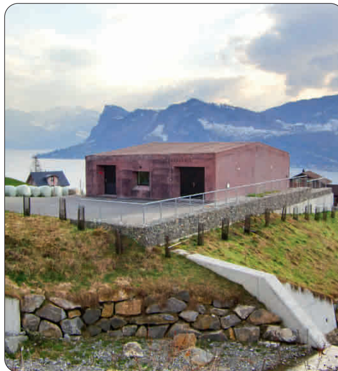
Reservoir Schönegg: Die Gemeinde lädt ein zum Tag der offenen Tür mit Festakt.
