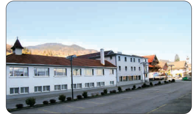
Seestrasse 3, im linken Gebäudeteil oben: Öffentliche Besichtigung am 1. Mai, 15.30 Uhr. Bild Thomas Vaszary
