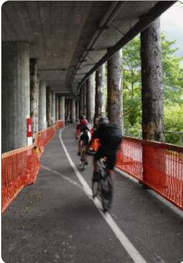
Neuer Veloweg anstelle der Pontonbrücke.
