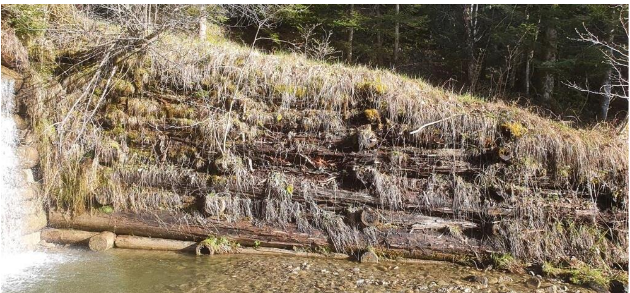
Abbildung 5: Längsverbauung des linken Ufers zwischen den Sperren 1 und 2
