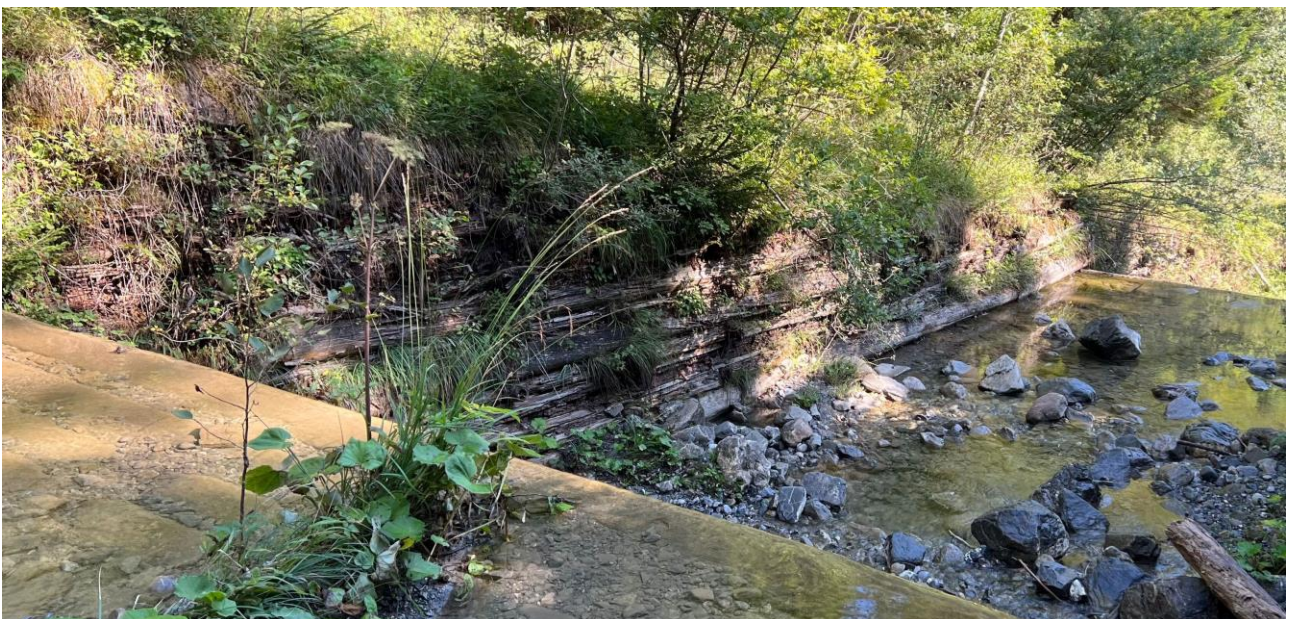
Abbildung 4: Längsverbauung des linken Ufers zwischen den Sperren 4 und 5
