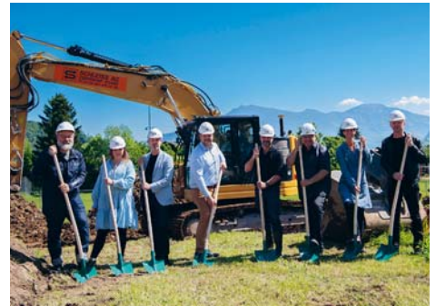
Jetzt wird auf dem Areal Matt gebaut. (PD)
