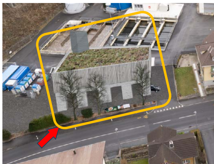
Abbildung 3: Ansicht Energiezentrale / Sammelstelle
