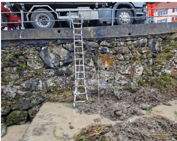
Abbildung 3: Zustand bei Kernbohrungen
