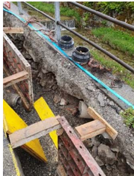
Abbildung 4: Rückseite Leitmauer (rechts)
