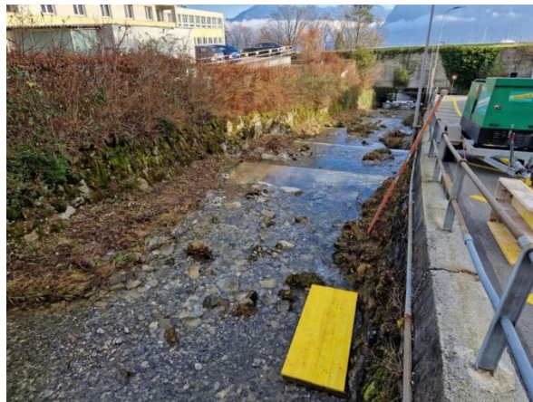
Abbildung 10: Risse in Brüstungsmauer.
